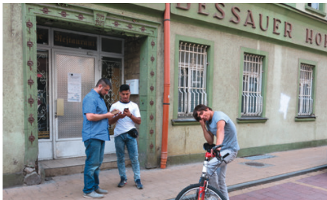
Der umgebaute Dessauer Hof: im Interkulturellen Zentrum ist auch die einzige Moschee von Merseburg untergebracht
